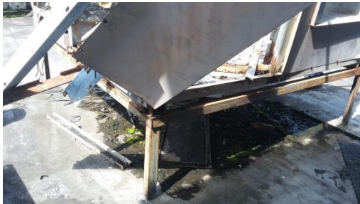
Materiales por Desalojar.
