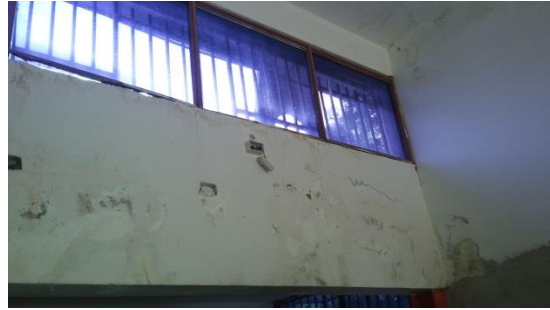
Ventana y Paredes Internas.
