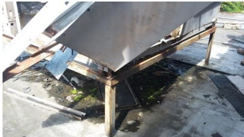
Materiales por Desalojar.
